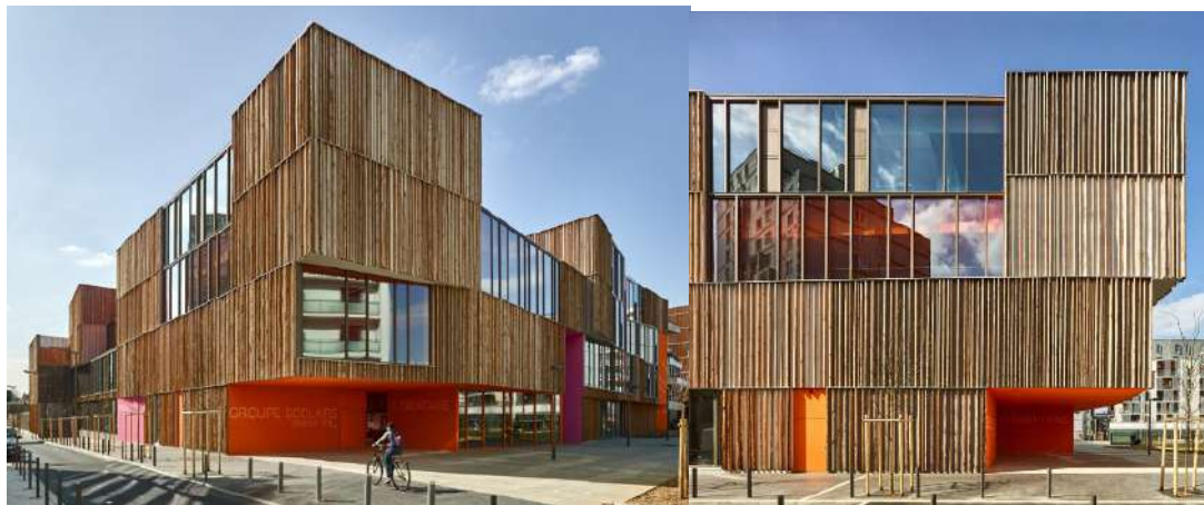
Рисунок 10 – Школьный комплекс в Коломбе
