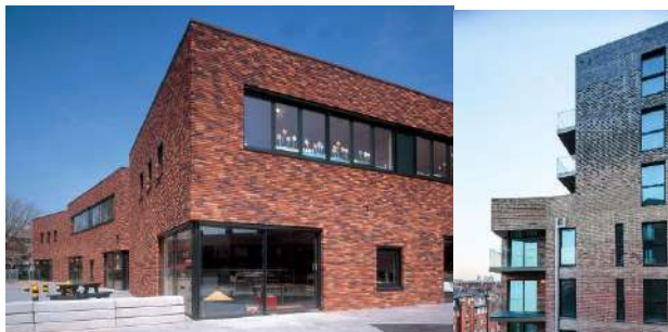
Рисунок 1 – Фасад здания, кирпич
