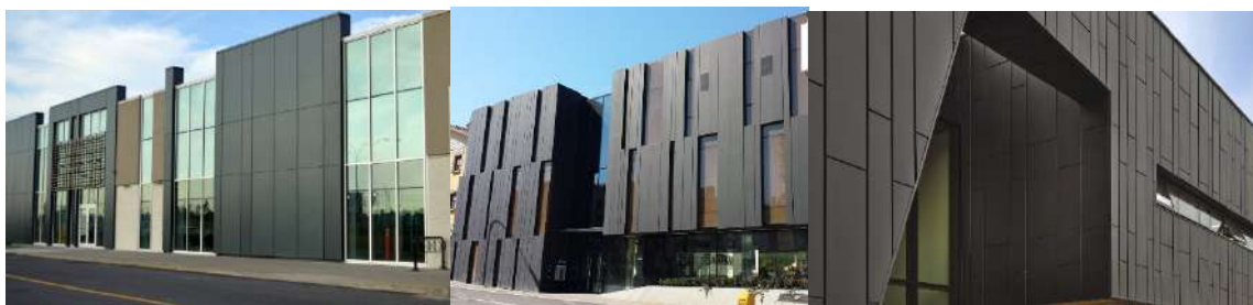
Рисунок 2 – Фасад здания, фасадные кассеты
