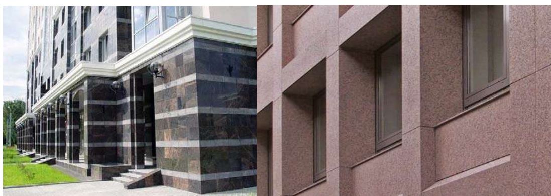
Рисунок 4 – Фасад здания, натуральный камень и искусственный камень
