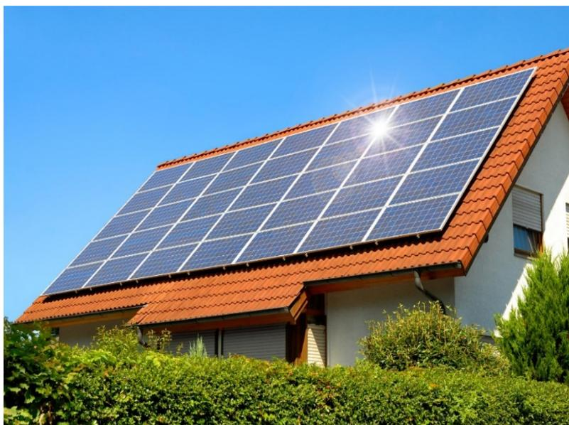
Рисунок 2 – Солнечные батареи, установленные на крыше жилого дома
